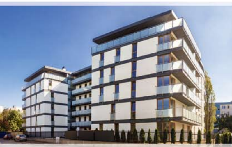
KAMIENICA DWORSKA ul. Twardowskiego
